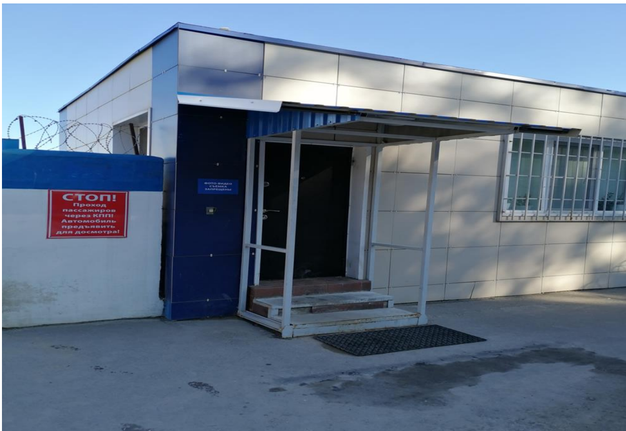
Крыльцо автотранспортной проходной
