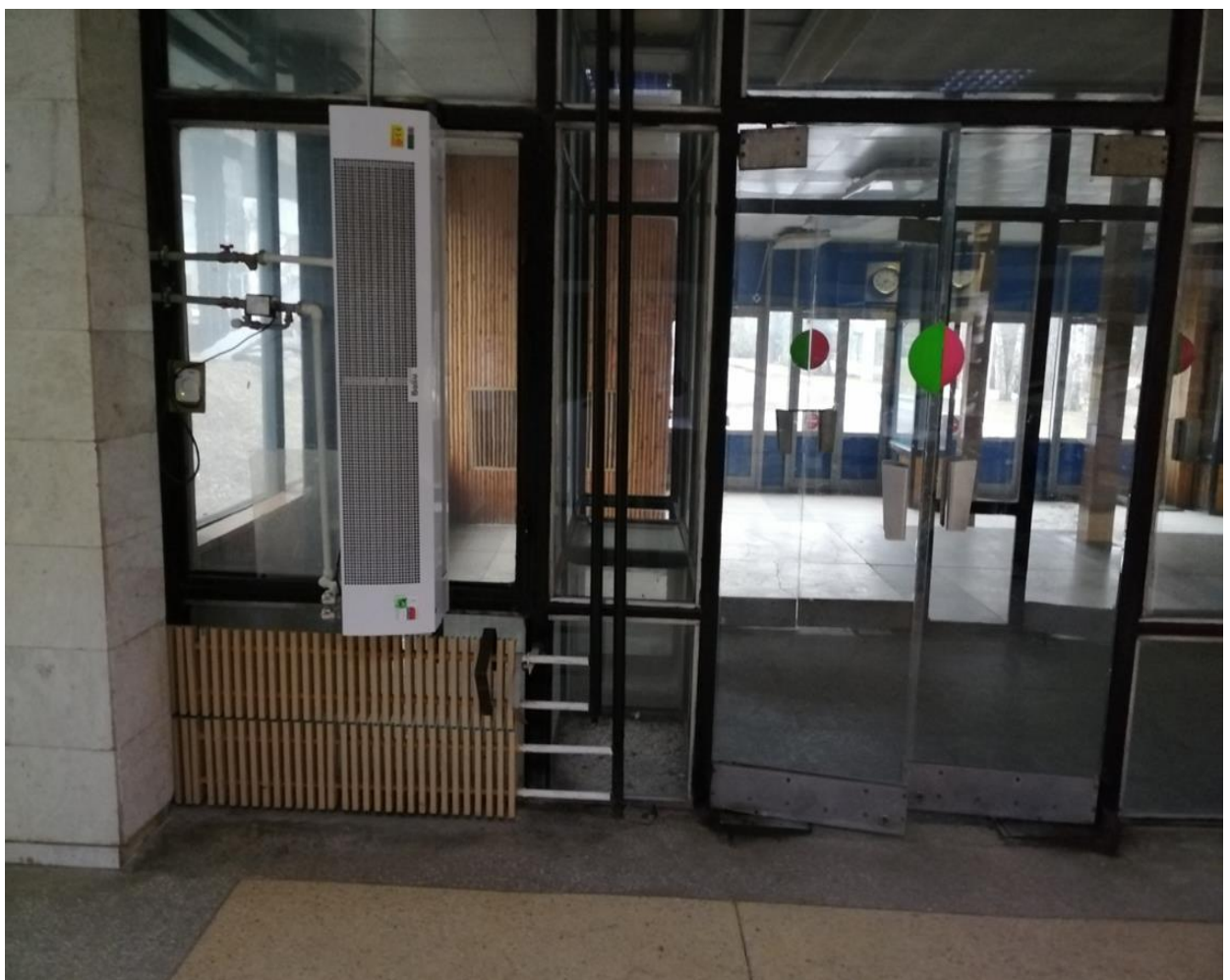
Установка воздушных завес на проходной
