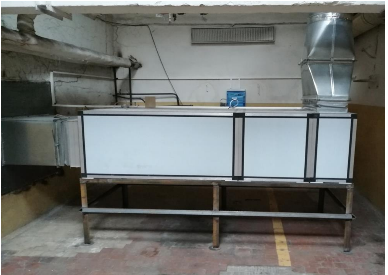
Монтаж воздуховодов и приточно-вытяжной системы
